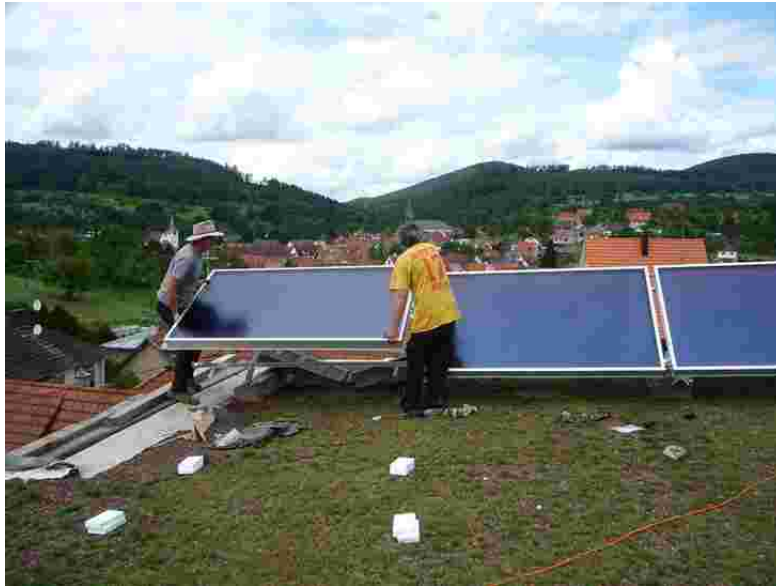
Abbildung 4: Solarthermie wird aufgebaut
